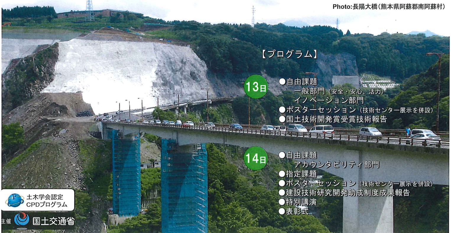
Photo:長陽大橋(熊本県阿蘇郡南阿蘇村)
