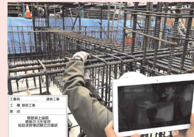
Webカメラを利用した遠隔検査
